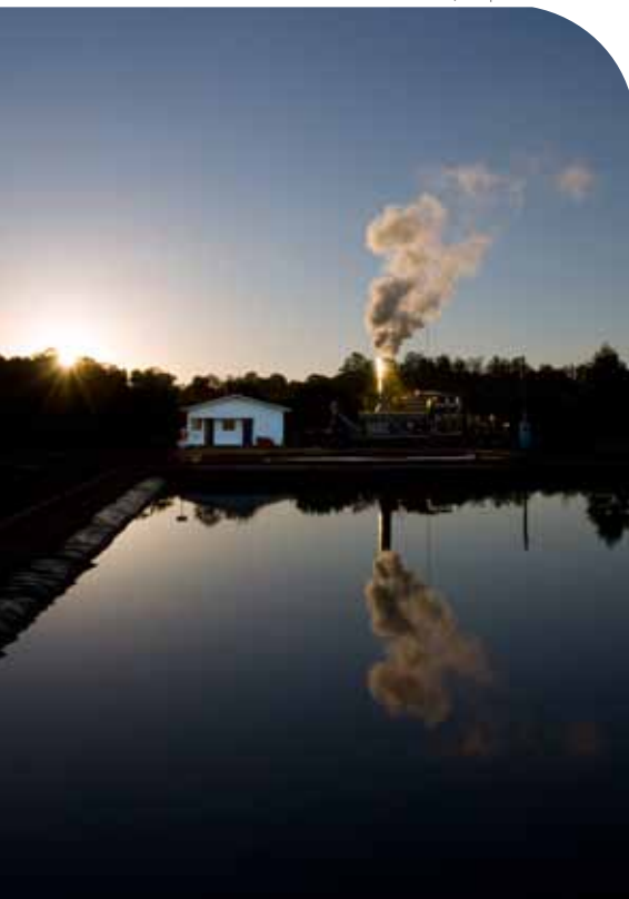
Evaporador de chorume em atividade no aterro de São Leopoldo (RS)
