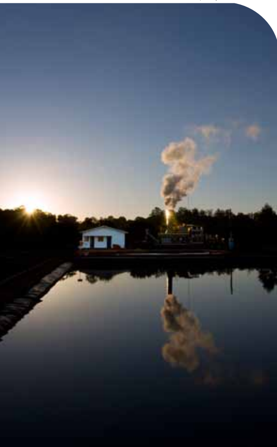
Evaporador de lixiviado en actividad en el relleno sanitario de São Leopoldo
