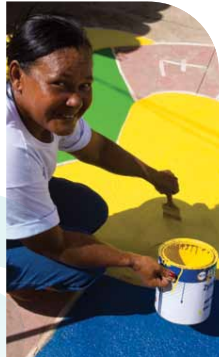
Pintura no CMEI de Coqueiro Alto, em Itapoã
